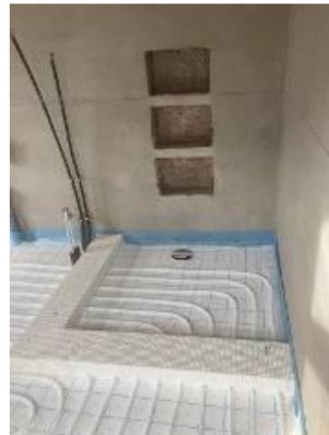
Hier wurde ein alter Kuhstall und Anbau saniert. Es waren eine Menge Leitungen und Medienträger in das SGS einzubauen. Der Bauherr wollte einen hohen Dämmwert, aber auch Feuchteschutz erreichen. Er schüttete eine erste Lage SGS und verlegte in diesen 15 cm seine Medien. Stabilisierte diese in einem Geotextil und seitlich mit einem erdfeuchten Beton. Dann wurde eine zweite Schicht mit 15 cm eingebaut. Damit wurde eine sehr gute Wärmedämmung und Tragschicht für den weiteren Bodenaufbau realisiert.
